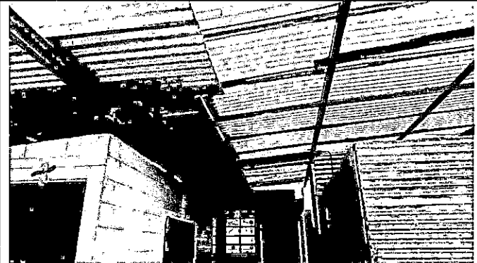
Foto 4: Techo de aula en mal estado
